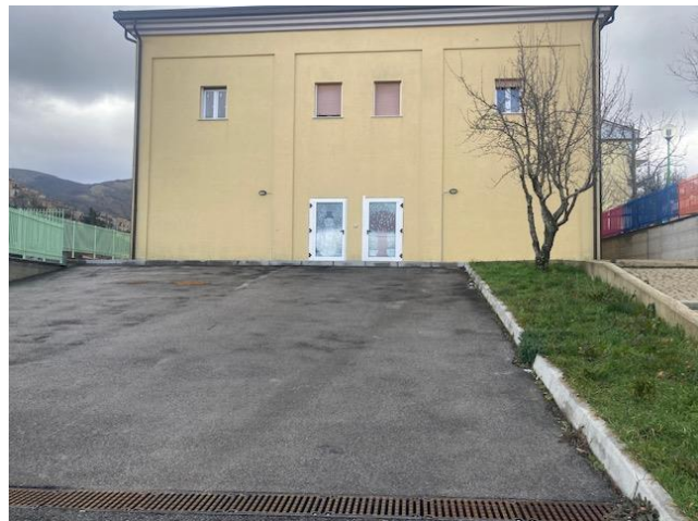
Punto di raccolta Piano Terra
